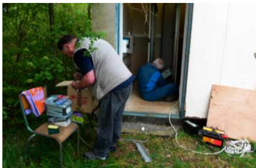
Préparation après mise en place de la nouvelle. Organisation des différents branchements par F5FYU.
